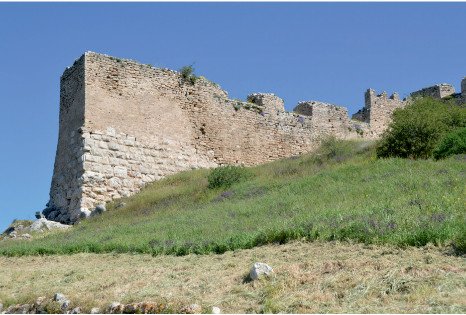
Akrokorinth MA/NZ Befestigung über C/HL Quadermauerwerk Photo E. Mlinar
